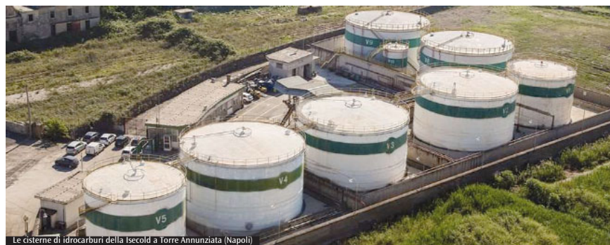
Le cisterne di idrocarburi della Iscolad a Torre Annunziata (Napoli)
