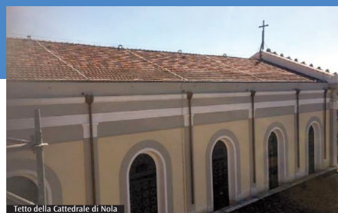
Tetto della Cattedrale di Nola
